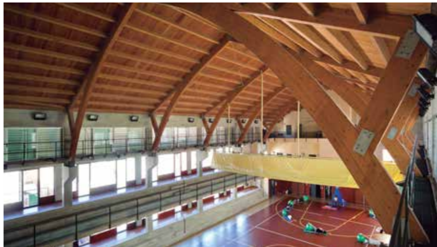
Foto: Edificio Deportivo y Asistencial Centro Estel, Ayuntamiento de Palma. Ricardo Santonja
