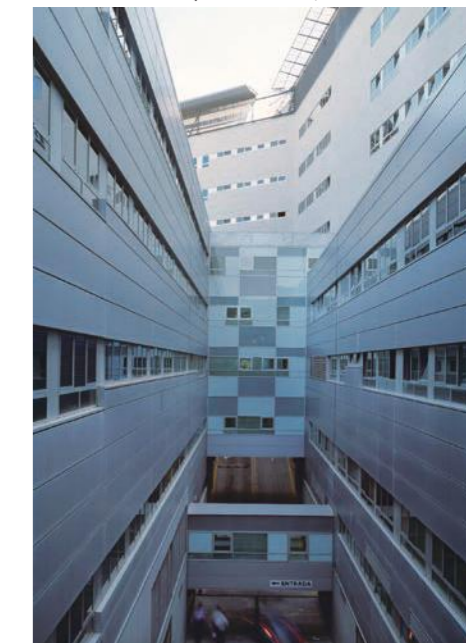
Foto: Hospital Reina Sofía, Murcia_ Foto Luis Asín
