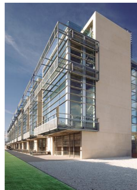
Foto: Edificio de oficinas Alius en Las Rozas (Madrid)
