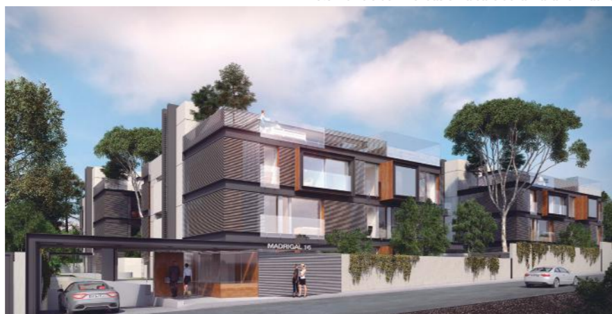
Foto: Edificio de viviendas en la calle de la Plaza 13. Madrid
