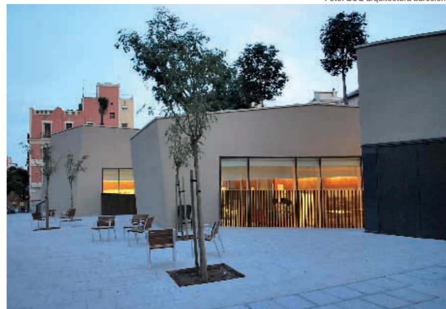
Foto: BCQ arquitectura barcelona
