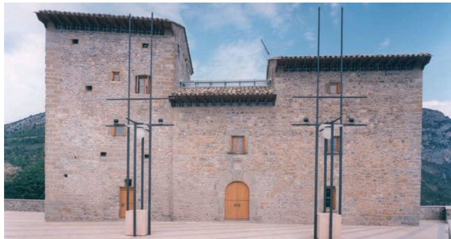
Torre de Ligüerre
