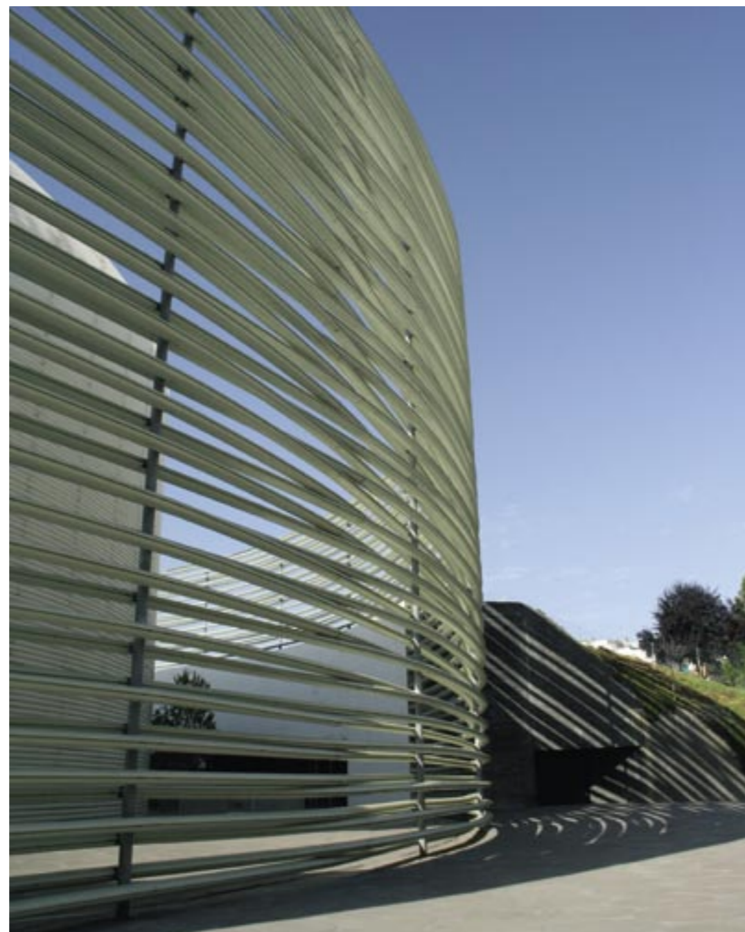
De izquierda a derecha: Tubos de plexiglás del anillo interior; Tubos de fibra de vidrio y poliéster del anillo exterior; Zona de asientos bajo la silueta del graderío del auditorio. Fotos: Promateriales
