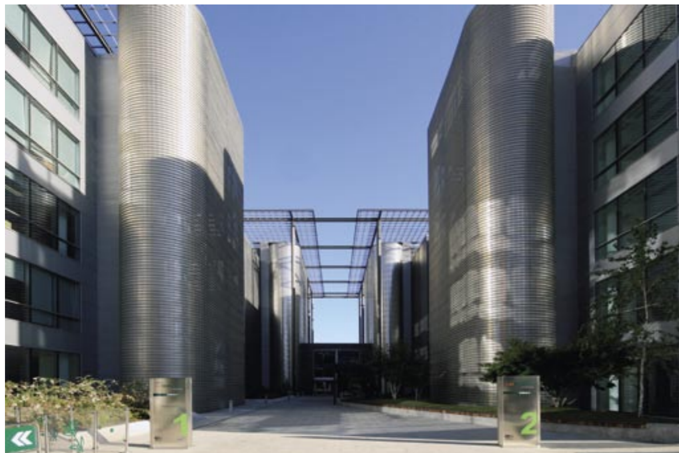
Acceso al hall central de los edificios A (1) y B (2). A los lados, las escaleras de emergencia cubiertas por chapa de aluminio. Foto: Promateriales
